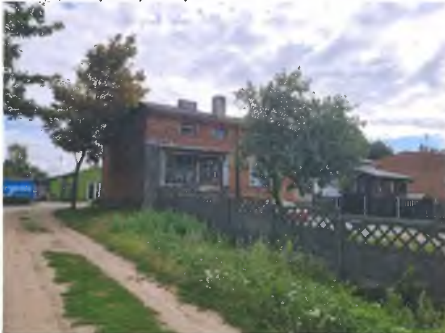
Fotografia 11 Brak poprawnej izolacji w budynku
