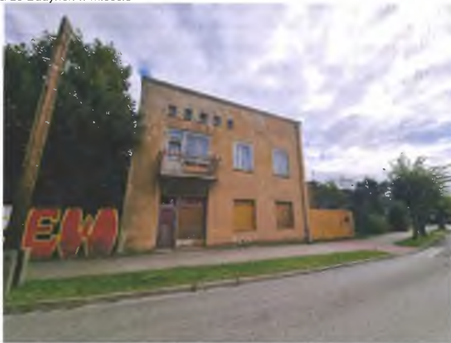
Fotografia 20 Budynek w mieście
