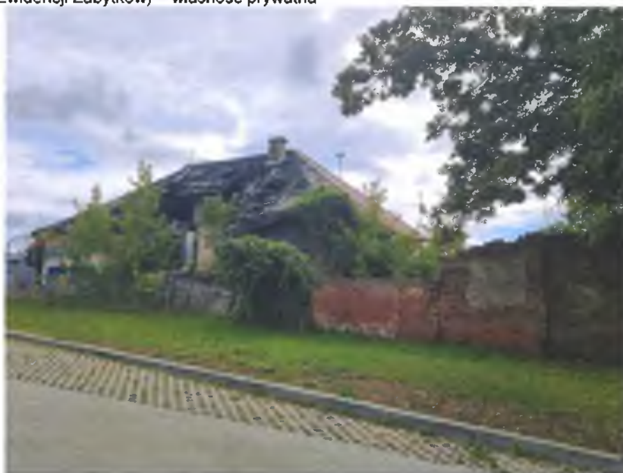
Fotografia 21 Obiekt w centrum Strykowa (zabytek wpisany do Wojewódzkiej Ewidencji Zabytków oraz Gminnej Ewidencji Zabytków) – własność prywatna
