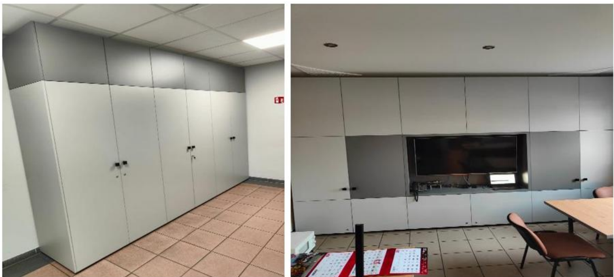
Zdjęcie 55. Szafy na korytarzu oraz stołówce
