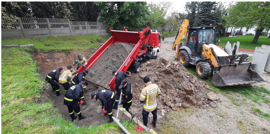
Zdjęcie 25. Prace przy wybrukowaniu placu manewrowego
