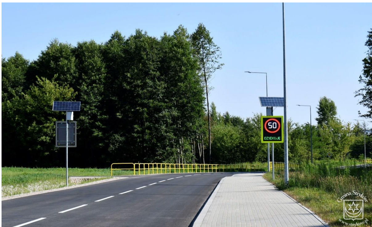
Fot. Droga gminna Smolice
