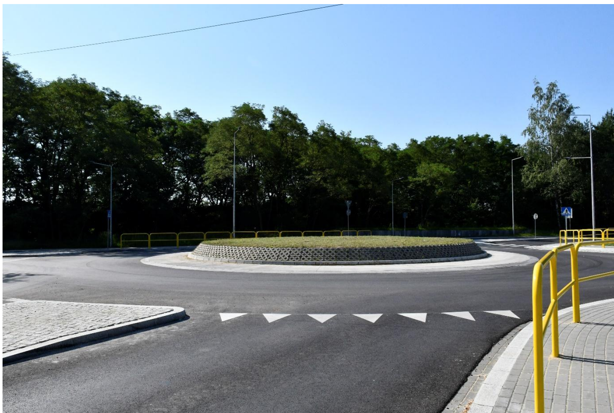
Fot. Rondo na drodze powiatowej w Smolicach
