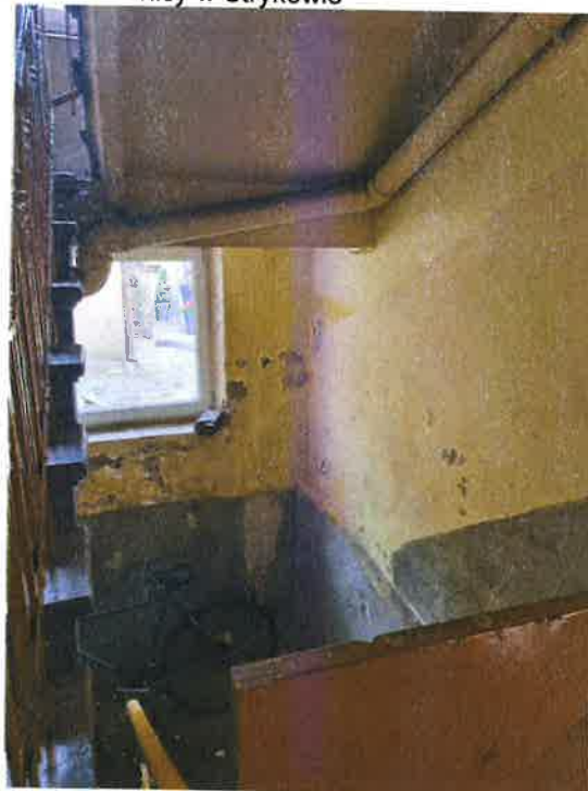
Fotografia 23 Klatka schodowa kamienicy w Strykowie
