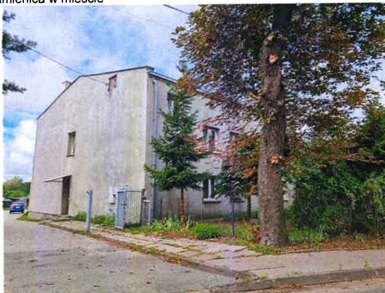
Fotografia 24 Kamienica w mieście
