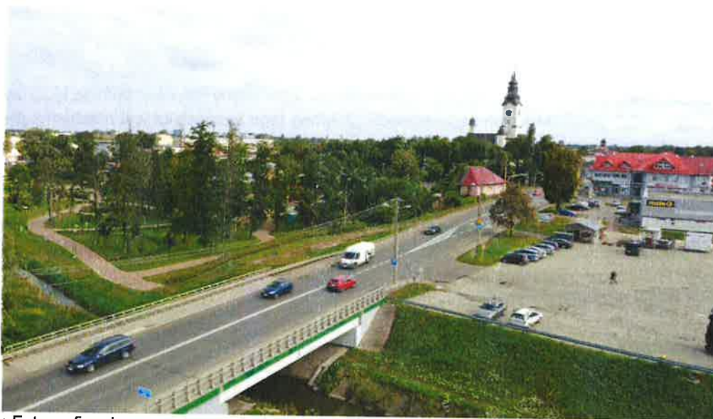
Fotografia 8 Droga krajowa nr 14 w Strykowie
