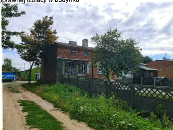
Fotografia 11 Brak poprawnej izolacji w budynku
