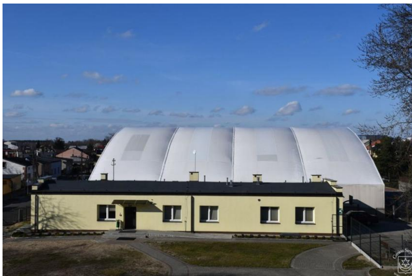
Balon przy SP1 w Strykowie. fot. Gmina Stryków
