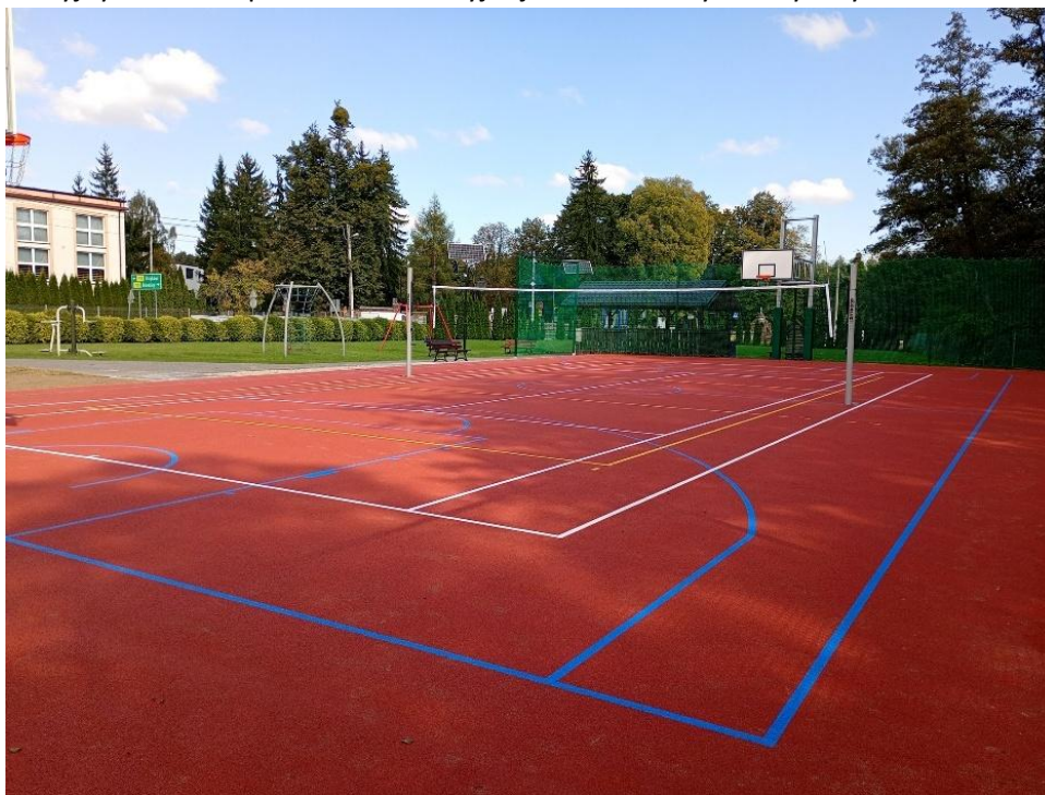
Boisko wielofunkcyjne w Niesułkowie Kolonii. fot. Gmina Stryków
